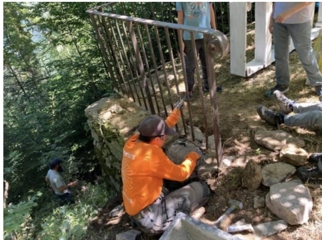
Réfection du mur de soutènement du garde corps
