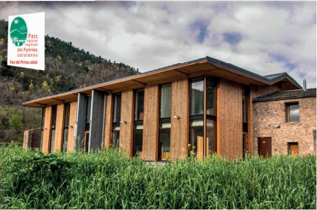
La réhabilitation d'une ancienne bergerie en maison du Parc des Pyrénées catalanes, à Olette, en périmètre de monument historique intègre les principes de l'éco-construction (performance thermique, utilisation du bois local, chaufferie bois...) et montre une démarche exemplaire pour les visiteurs. Source Bois et Énergies 66.
