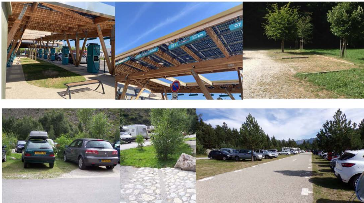
Exemples d'ombrières avec structures bois et de parkings végétalisés et perméables
