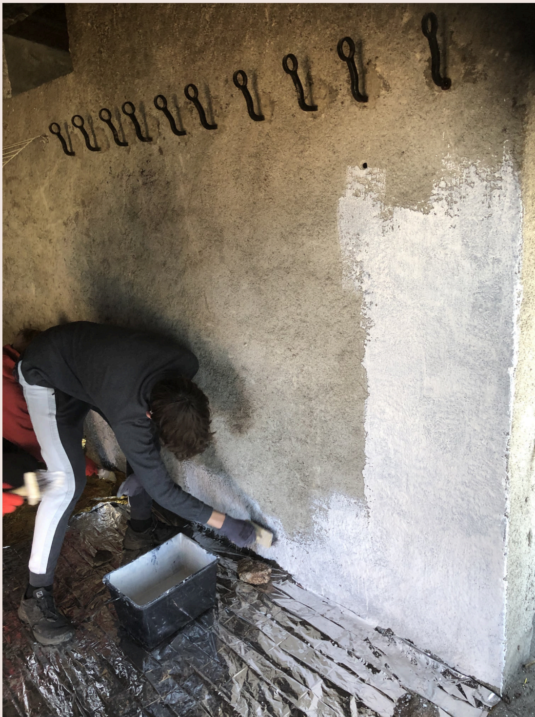
Enduit à la chaux, refuge de Boucacers (SMCGS, 2023)
